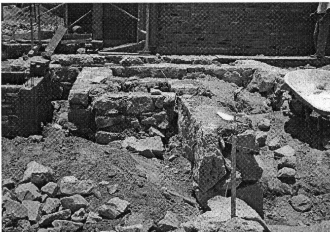
Figura 3.16 Cimentación de Profinka
