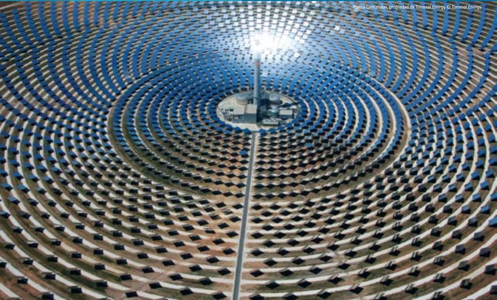
Gemasolar, planta termo-solar de 20 megawatts localizada en Andalucía, España. La planta cuenta con 2,650 espejos móviles (heliostatos) que enfocan la radiación solar en una torre central de 140 metros de altura.
