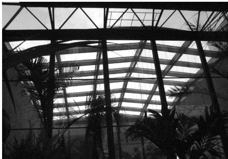
Foto 3a. La pantalla de cristal se arma con el esqueleto metálico
