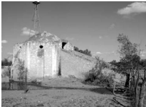
Foto 8. Noria con cúpula de media esfera y planta octagonal.
