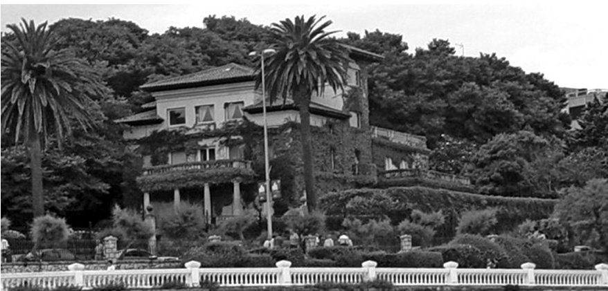
Villa Piquío, Santader, España, 2004. Fotografía del autor.
