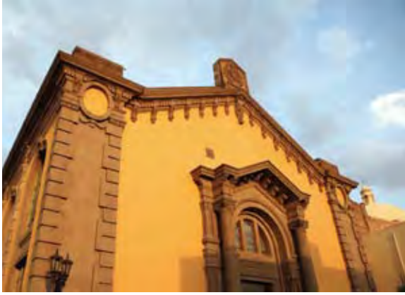
Remodelación de la Biblioteca Central Universitaria
