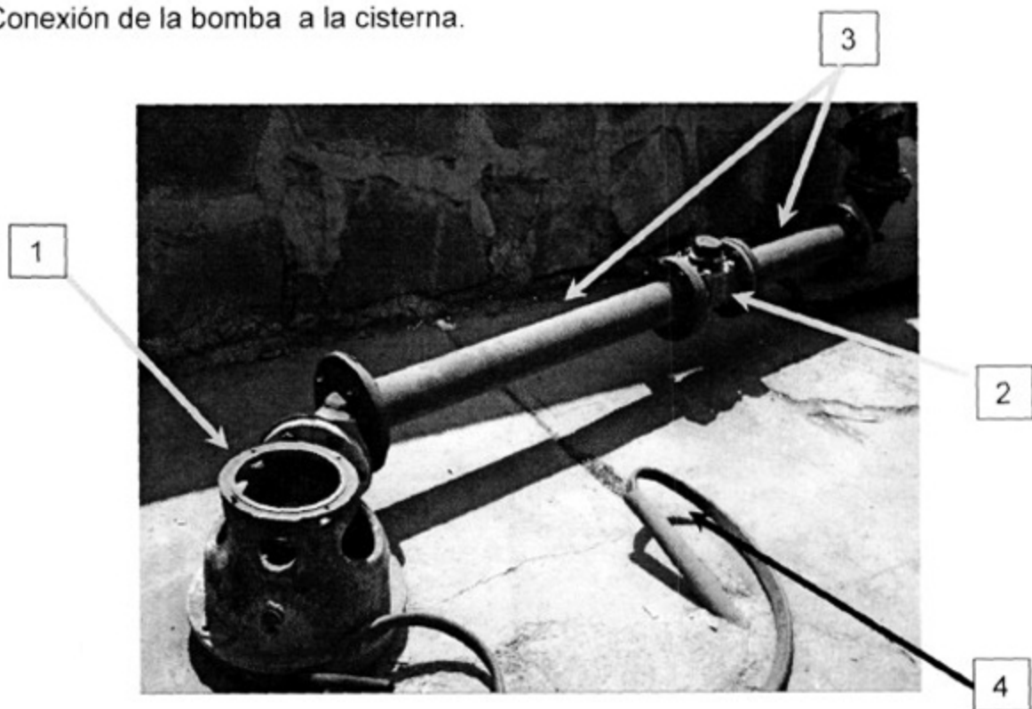
Lámina D.1 conexión de pozo.
