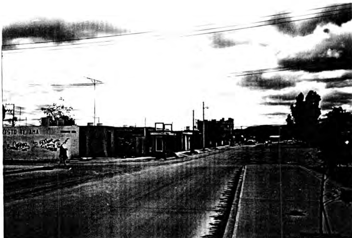
Esta es la calle de Prolongación Constitución, principal vía de acceso al terreno
