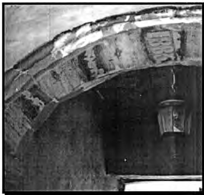
Datación en la clave de arco de acceso de la casa grande.
