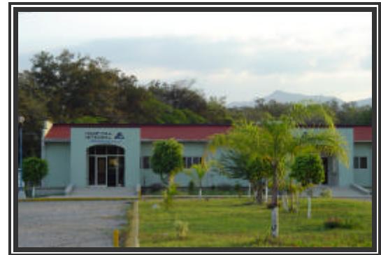
IMAGEN 11: Hospital Regional, SSA. Achiquico. AUTOR. 2004
