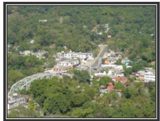
IMAGEN 5: Vista panorámica de la cabecera municipal de Tamazunchale. AUTOR
