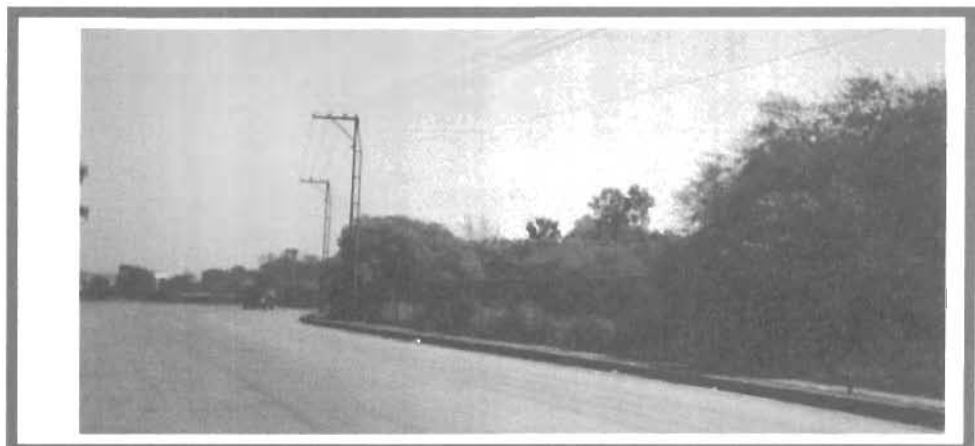
A) RED ELÉCTRICA Y PAVIMENTO
