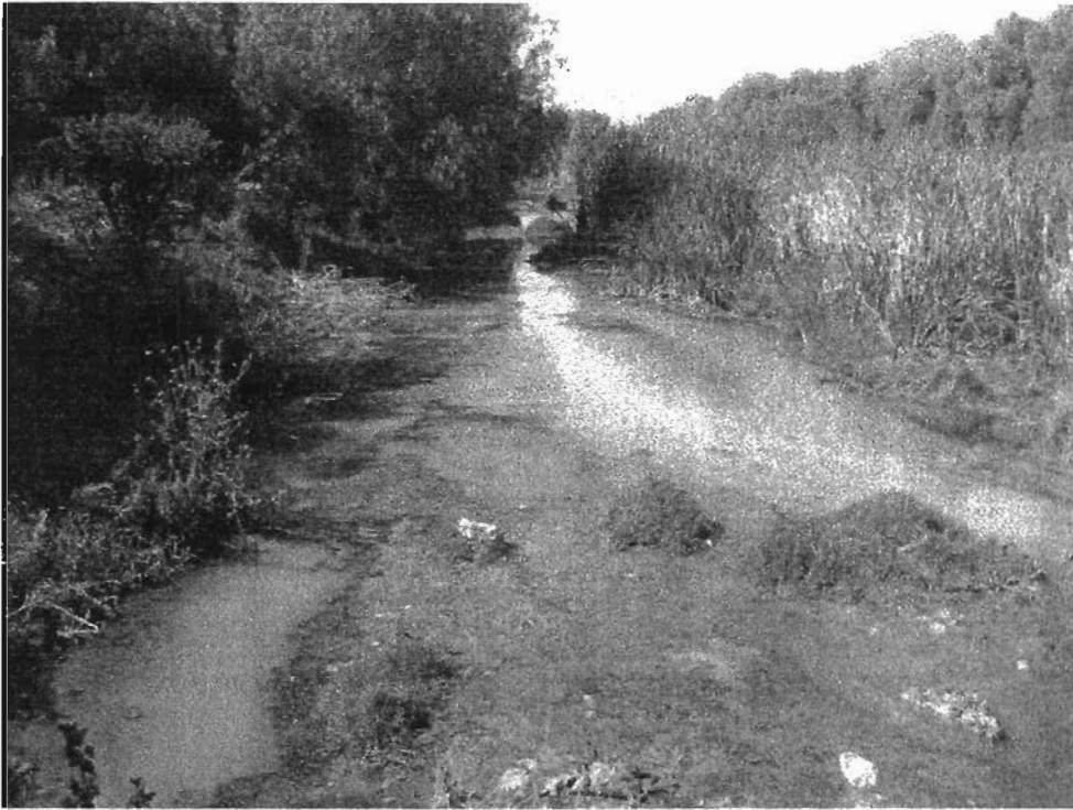
Figura 2. Fotografía del canal de alimentación al Tanque Tenorio.
