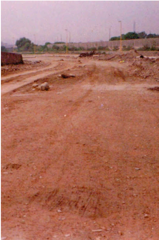
Soil leveling and compaction | Nivelación y compactación de terreno
