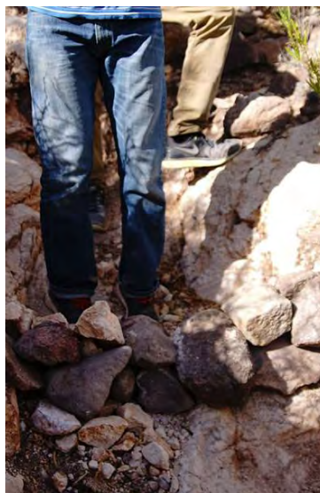
Daniel Jaramillo demonstrating the construction of a mini-dam | Daniel Jaramillo demuestra la construcción de una minipresa
