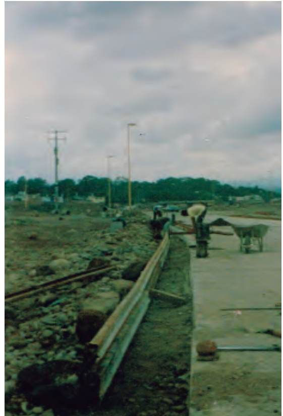
Curbs' metallic moulds | Cimbra metálica para guarniciones
