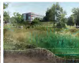
Vegated detention basin | Depósito de retención vegetada
