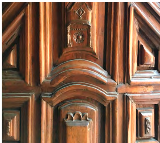
Wooden door detail | Detalle en puerta de madera
