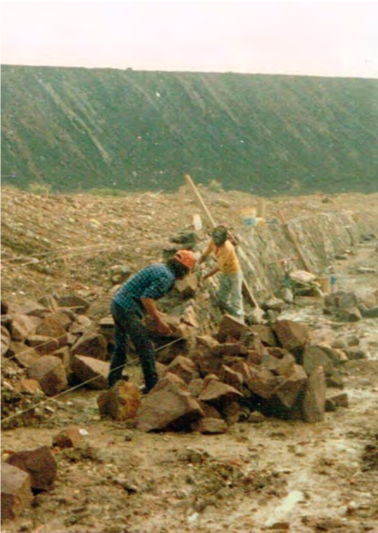
Construction of initial stone curbs | Construcción de primeras guarniciones de piedra
