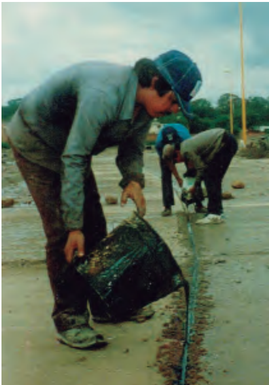
Reparation of damages due to rainwater | Reparación de daños por lluvias
