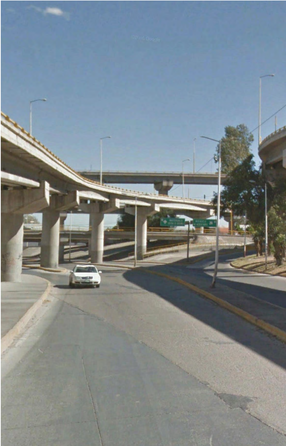
Transit overpass in the city | Pasos a desnivel en la ciudad
