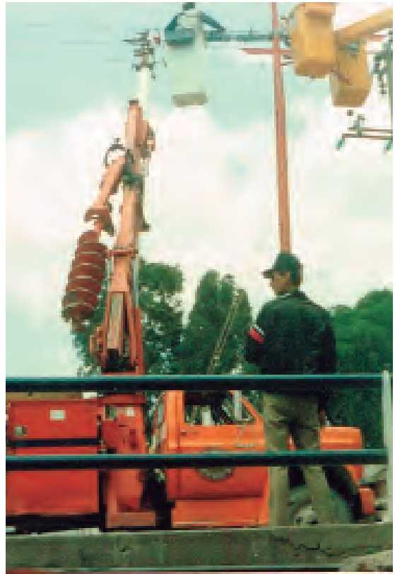
Electric substation placement | Colocación de subestación eléctrica
