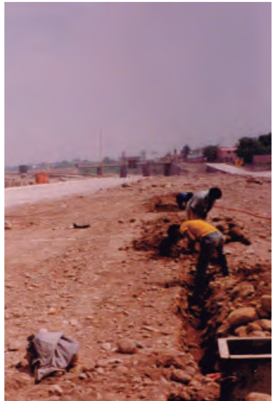
Electrical excavations | Excavaciones eléctricas
