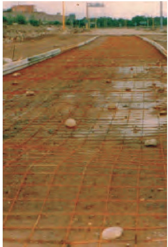
Steel structure before pavement | Estructura de acero antes de pavimentar
