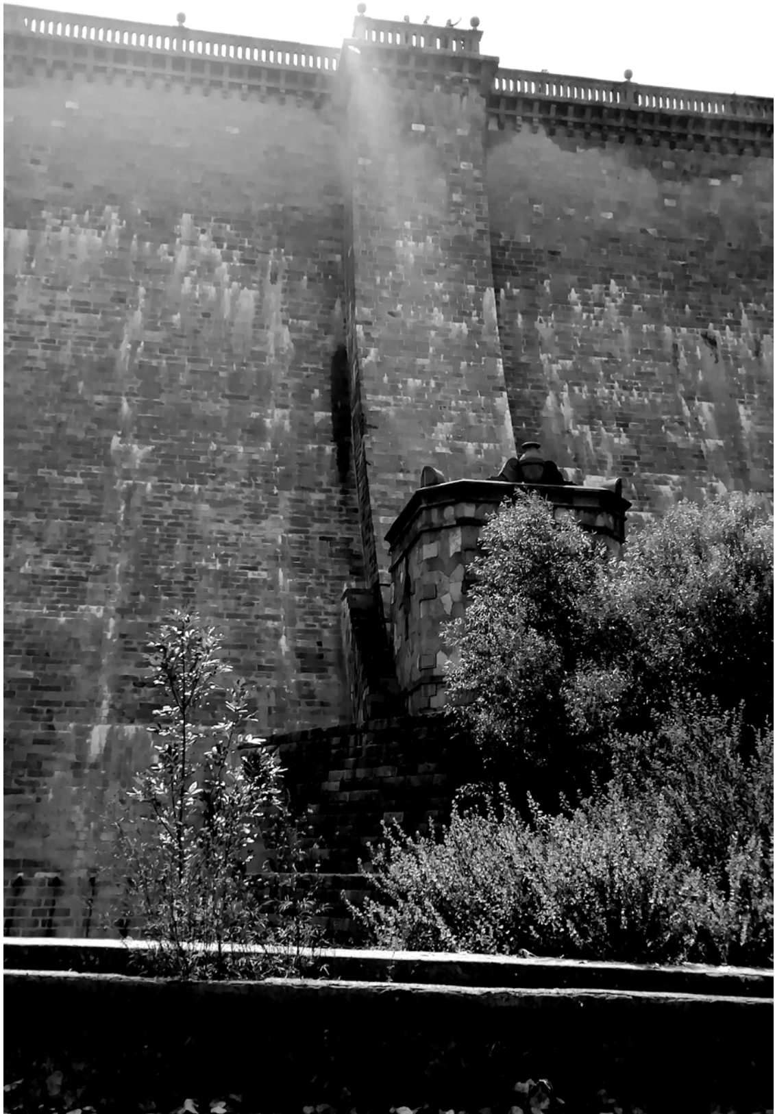
San Jose dam wall | Cortina de la presa San José
