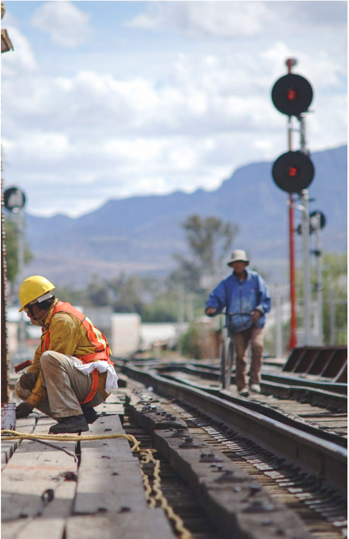
Railway workers | Trabajadores de la vía férrea
