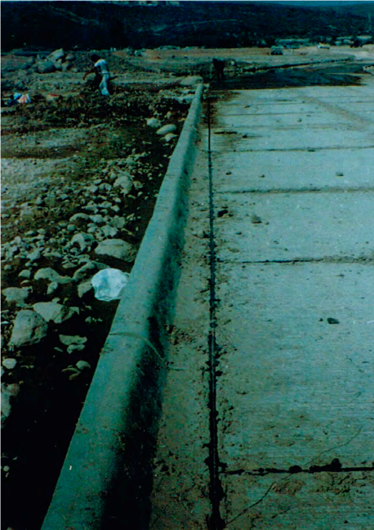
Pavement's dilation joints | Juntas de dilatación en el pavimento
