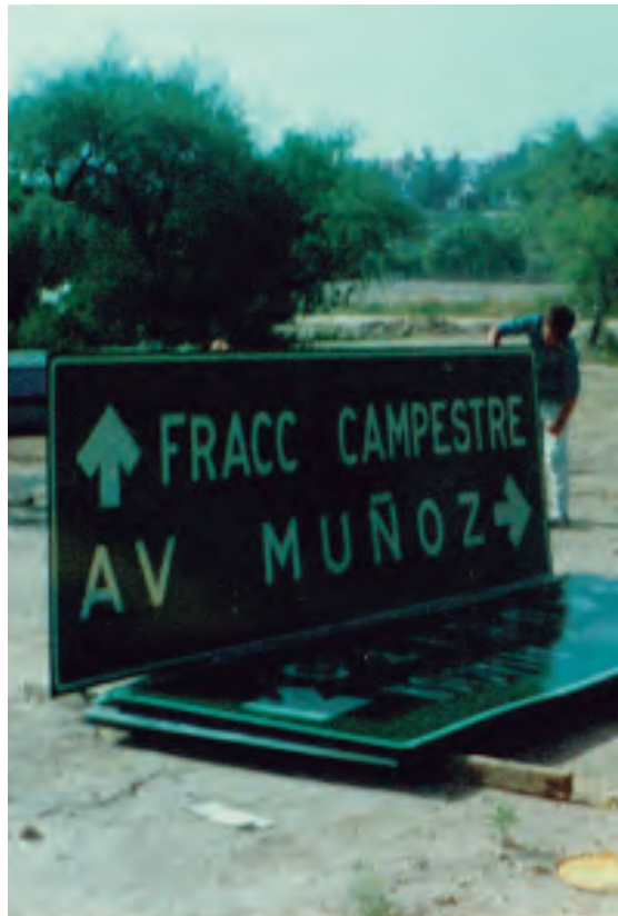
Sign post placement | Colocación de señalamientos
