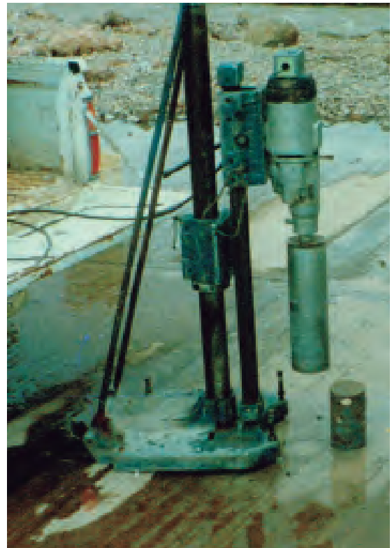
Concrete quality evaluation | Evaluación de calidad del concreto
