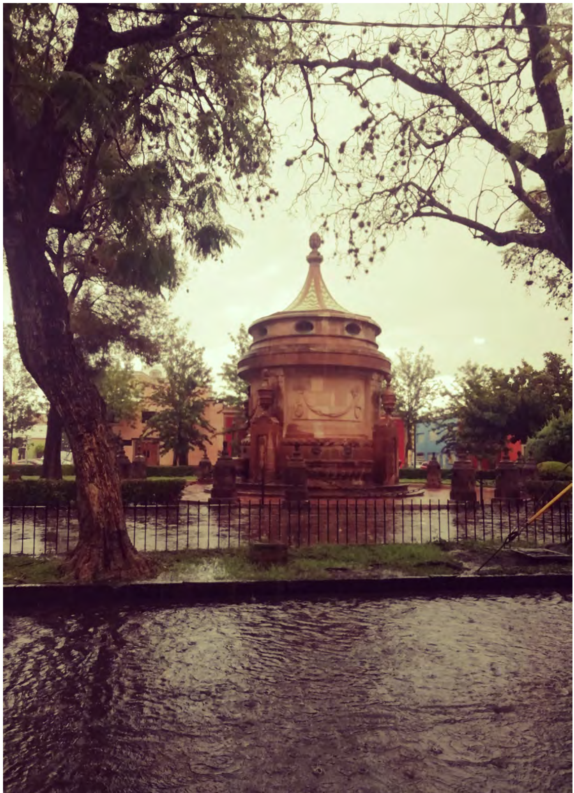
Water reservoir | Caja del agua
