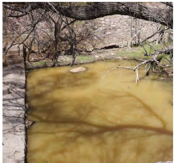
Retention pond at San José dam | Estanque de retención en presa San José
