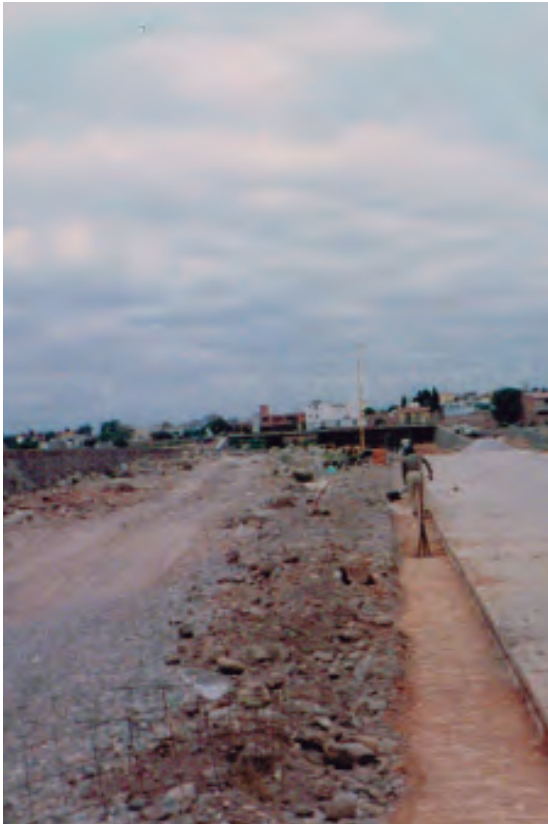
Dilations joints filling | Relleno de juntas de dilatación
