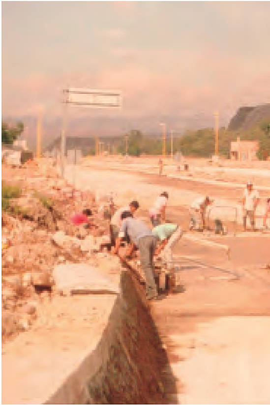
Finishing off the paving works | Finalizando la pavimentación
