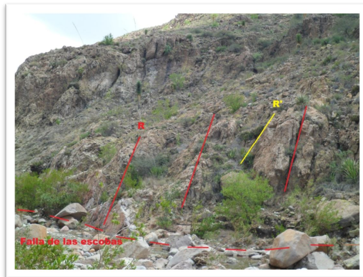
Figura 15.- Fotografía de la falla de las escobas mostrando las fracturas tipo Riedel.
