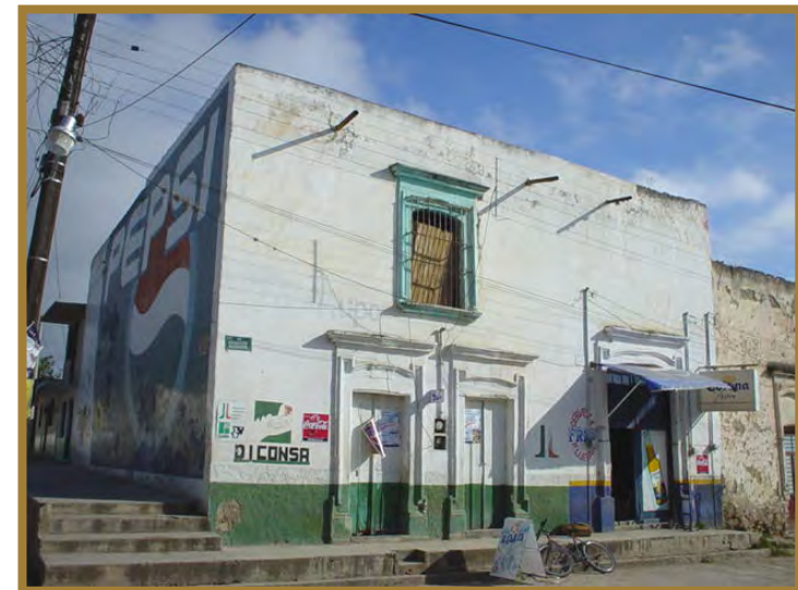
Ejemplo del mal uso de señalización.
