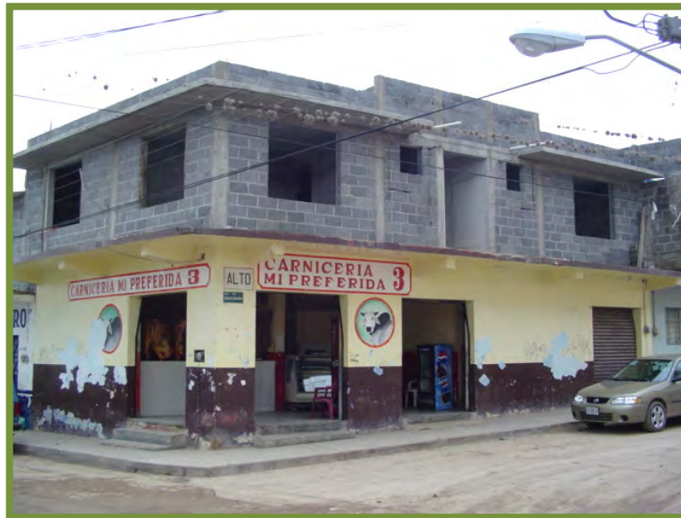
Ampliación de vivienda / calle Gral. Ignacio Zaragoza. Fotografía: No. 61 / H.L.V.P.
